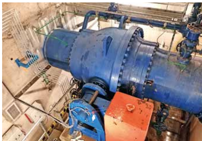
■ Hlavní uzavírací armatura v Doğançay
