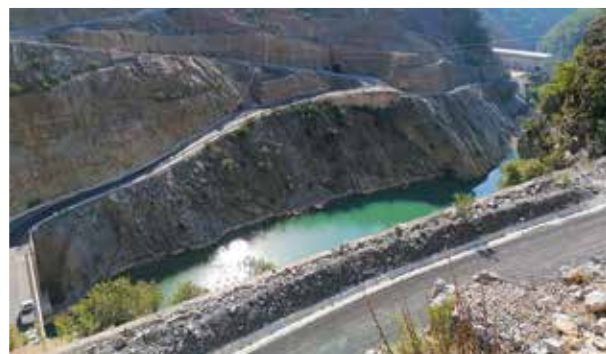
■ Říční koryto zařízlé do horského masivu – zdroj vodní energie
